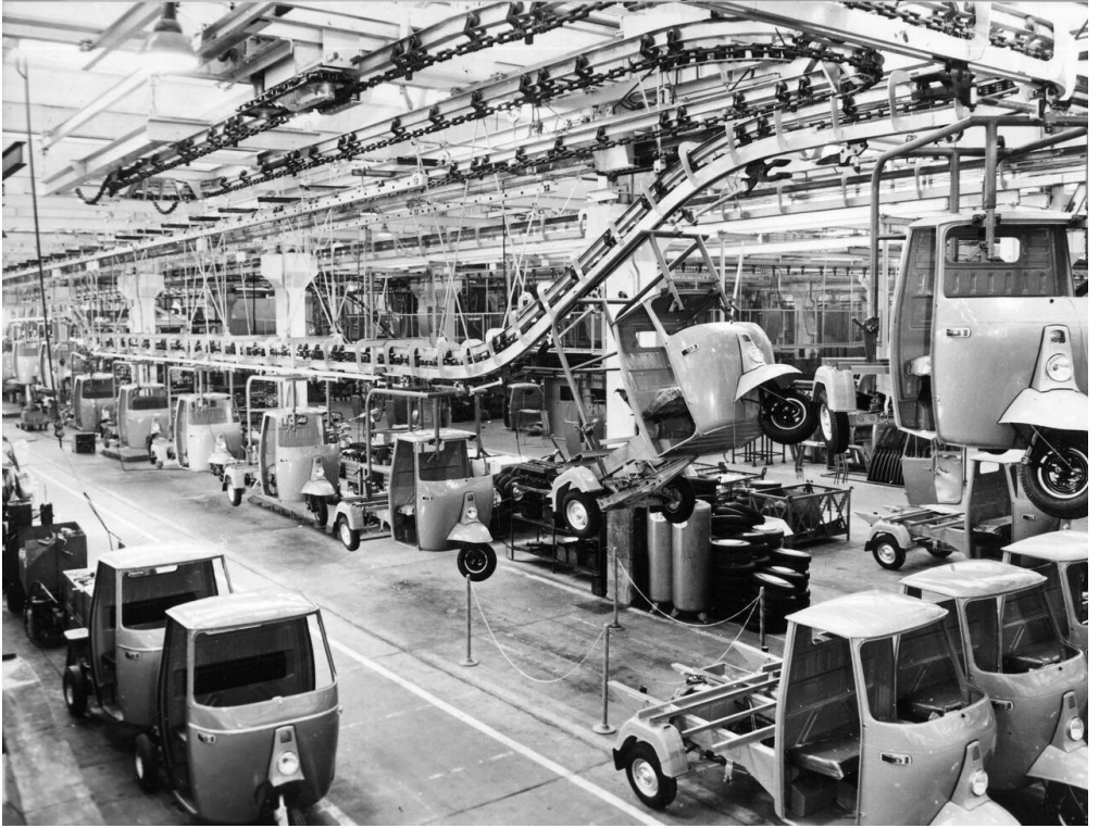
La catena di montaggio Ape nello stabilimento Piaggio di Pontedera, anni Sessanta.
